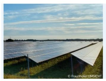
Kurzbeschreibung: Freiland- oder auch Freiflächen-PV-Anlagen sind auf Grund der verfügbaren Fläche und der optimalen Ausrichtung meist leistungsstärker als Dachflächenanlagen. Die Anlagen können sowohl fest ausgerichtet als auch ein- oder zweiachsig nachgeführt werden, um eine optimale Ausrichtung über den Tag zu erreichen.
