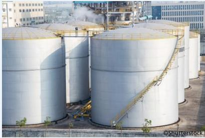
**Kurzbeschreibung:** Der Fernwärmespeicher entkoppelt Wärmezeugung und -bedarf. Es wird zwischen Puffer- bzw. Tagesspeichern und Langzeit- bzw. saisonalen Speichern unterschieden. Bisher gibt es in Deutschland allerdings nur wenige saisonale Fernwärmespeicher. Für beide Varianten gibt es verschiedene technische Ausführungen. [1]
